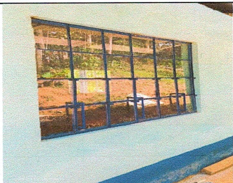
Foto 1: CAMBIOS DE VENTANAS DE MADERA POR VENTANAS DE METAL Y VIDRIO
