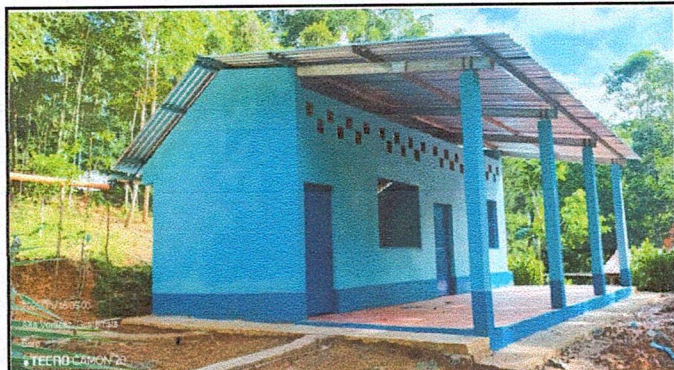
Foto 3: CAMBIO DE ESTRUCTURA METALICA Y LAMINAS C 26
